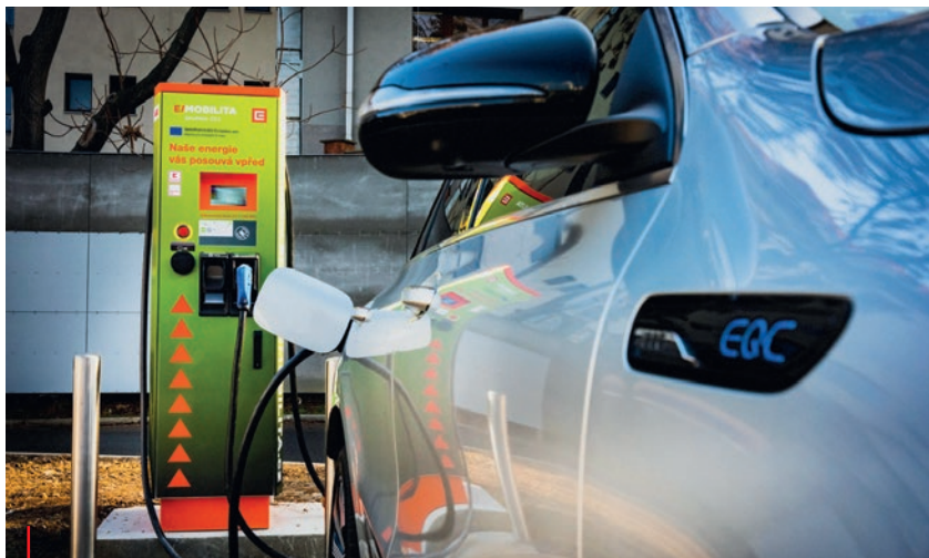
Za významným počtem dobíjecích stanic v ČR stojí ČEZ.
