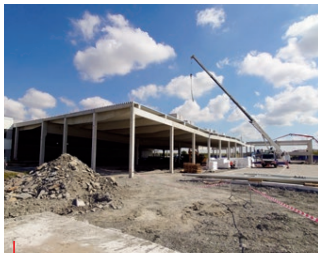
8. srpna 2020: Výstavba nové haly předmontáže a logistiky pro finální výrobu automobilů, která by měla být dokončena a připravena k provozu v první polovině příštího roku Foto: TPCA
