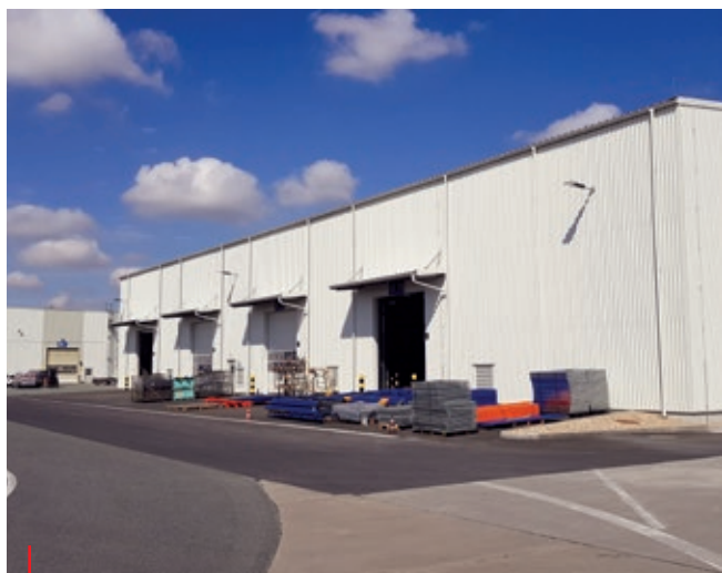
30. července 2020: Nové skladovací a logistické prostory před dokončením a testem vykládky materiálu a dílů nejen pro nové komponenty Foto: TPCA
