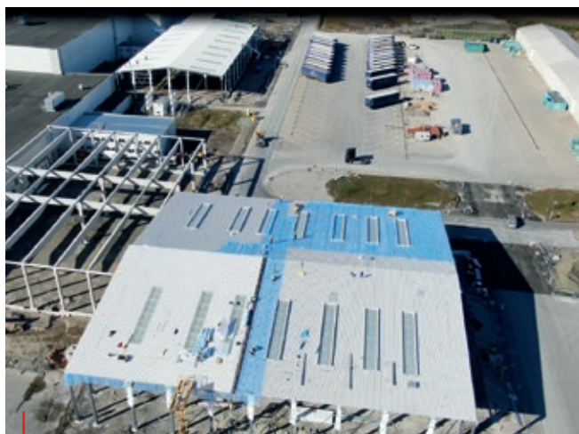
15. března 2020: Celkový pohled na výstavbu dvou nových hal pro oddělení lisovny a svařovny nových karoserií, které jsou plně funkční od srpna letošního roku Foto: TPCA
